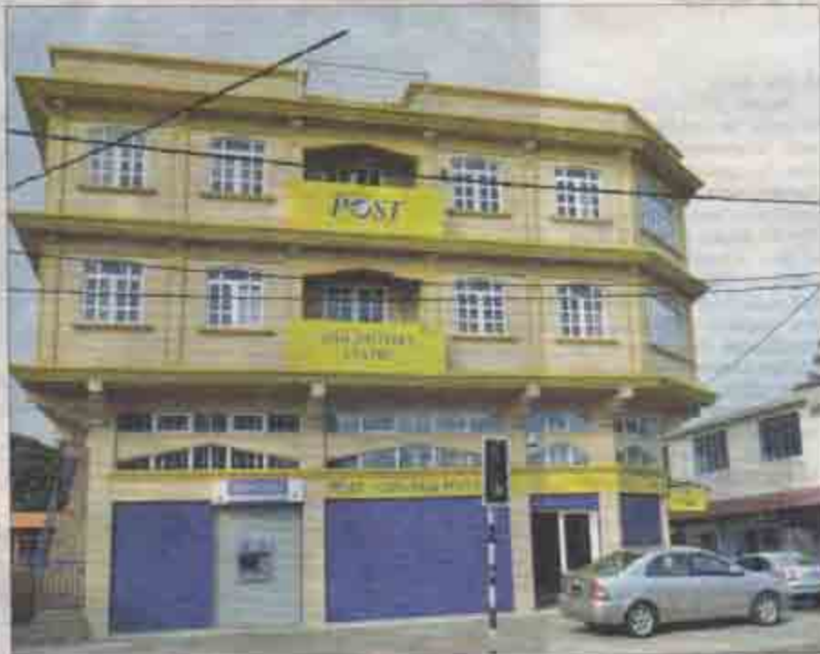
D'une superficie de 670 mètres carrés, le bureau de poste de Glen Park compte deux étages. Il fait également office de Mail Delivery Centre pour la région de Vacoas, Solferino et Floréal.
